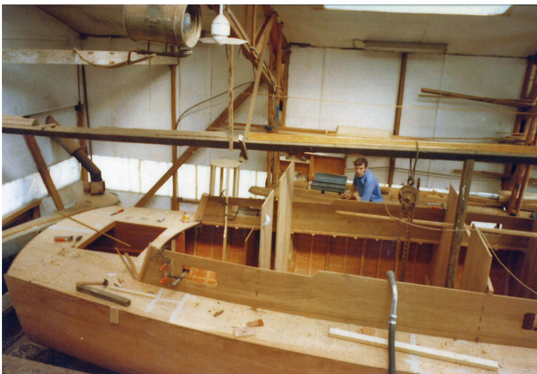
Her er dækket lagt, rufkarmene og hovedskot isat. Det er Henning Holmstrøm der udfører det meste af arbejdet.
